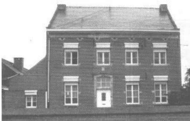
Fig. 127: Pand "Bellemi". Vanaf 1895 meisjesschool en woonst van de Zusters van Maria (Aerts 1993: 115).
