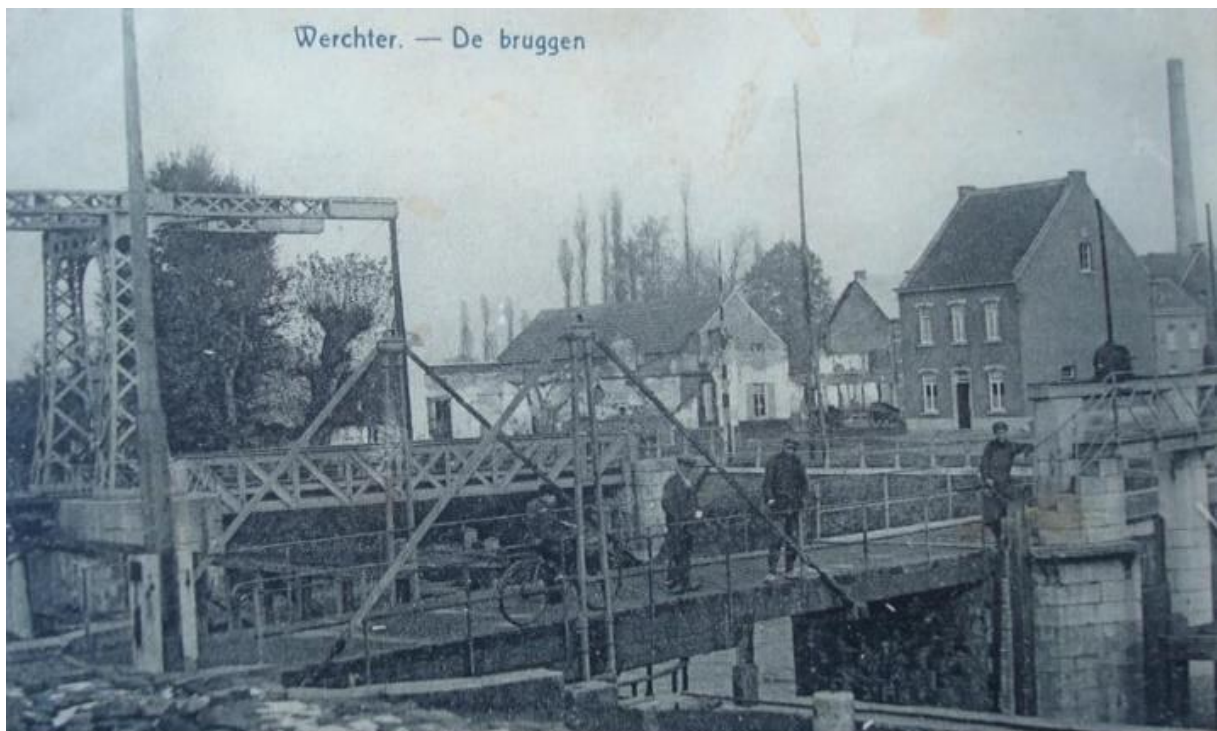
Fig. 111: Zicht op de twee bruggen, kort na WOI. Café 'Rome' staat nog centraal op wat nu de Tweebruggenstraat is. Rechts in de achtergrond het door oorlogsgeweld vernielde pand van zagerij Wouters ( www.delcampe.net )
