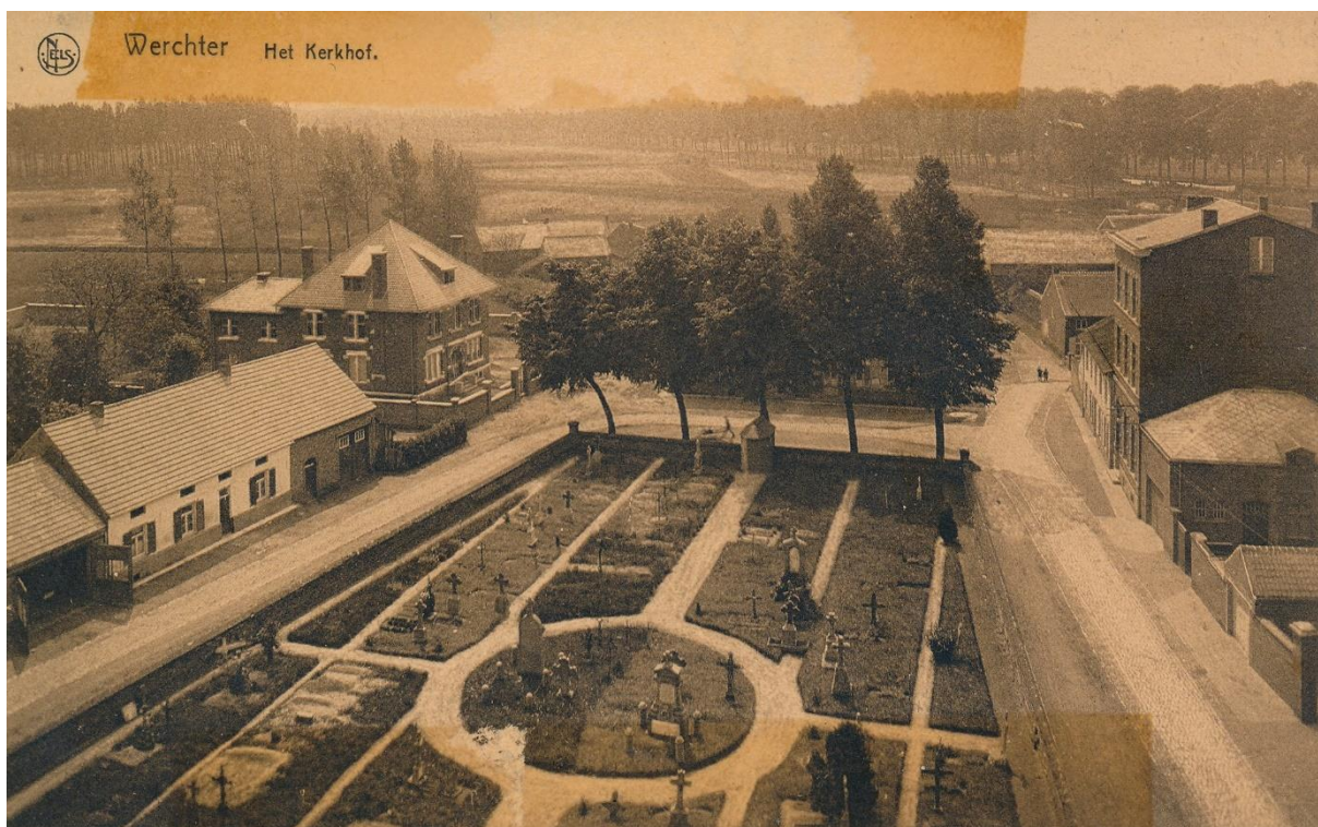
Fig. 70: zicht op het kerkhof na 1927. De oorlogsgraven in de rechterbovenhoek van het ommuurde kerkhof zijn geruimd. Links bovenaan ziet men de pas opgetrokken nieuwe pastorie, terwijl de paardenstallen van de brouwerij Van Roost (rechts onderaan) en het woonhuis van de dochter van Felix Van Roost (rechts bovenaan, drie bouwlagen onder zadeldak) klaarblijkelijk grotendeels aan de vernielingszucht van de Duitsers in 1914 ontsnapt zijn
