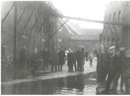
Fig. 82: Ondergelopen Pastorijsstraat met passerelle tijdens de overstromingen van 1965 (Voets 2010: 91)
