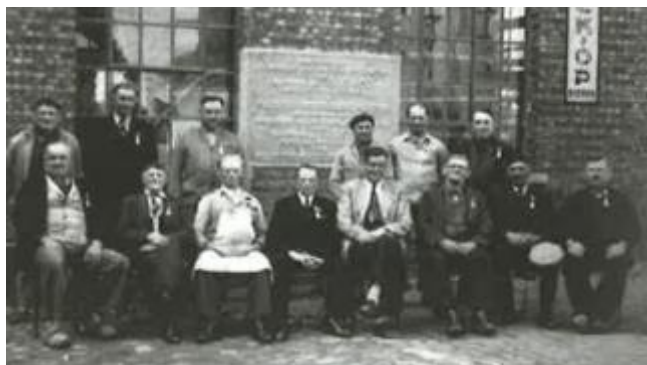
Fig. 74 en 75: In 1945 werd het 75-jarig bestaan van de brouwerij gevierd. Er werd een gedenkplaat onthuld. Deze werd tegen de gevel van de brouwzaal gemetseld en staat nu, na een grondige restauratie, voor het gebouw op de parking. (Voets 2010: 68 en © WinAr)
