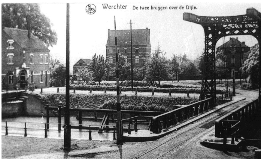
Fig. 102: de zogenaamde "Kleine Brug" (links) met sluisen en betonnen pijlers werd in WO II vernield en nooit meer hersteld. Bij de aanleg van de nieuwe brug werden ook de sluiswanden en de betonnen pijlers afgebroken. Uiterst links het sluiswachtershuisje, centraal houthandel Wouters en rechts café 'Rome' ( www.delcamp.net )
