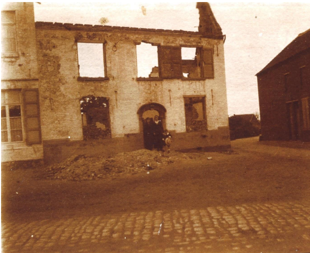
Fig. 129: Opnames van een nog onbekende fotograaf, genomen na de gevechten van 9-13 september en voor midden november 2014. Het verwoeste 17 de eeuwse huis; op de muurankers is 169x nog te lezen. (Minnen 2014: 201)
