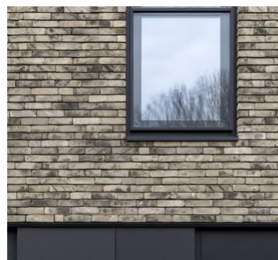
COMBINATIE GEVELSTEEN - DONKER PLAATMATERIAAL - ALUMINIUM BUITENSCHRIJNWERK
