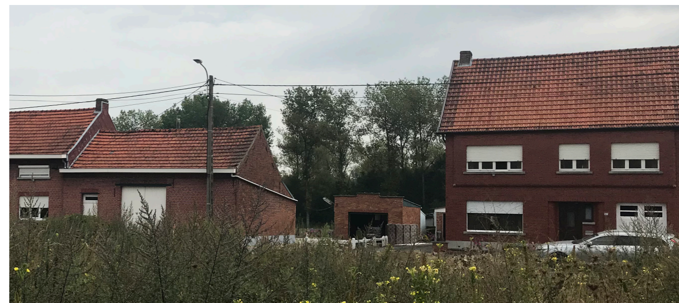
overzijde straat - Hoogland nr.90 (rechts op foto) - 92 (links op foto) - afd.2 sectie E nr. 783 XO & 782 NO - 1 à 2 bouwlagen met zadeldak
