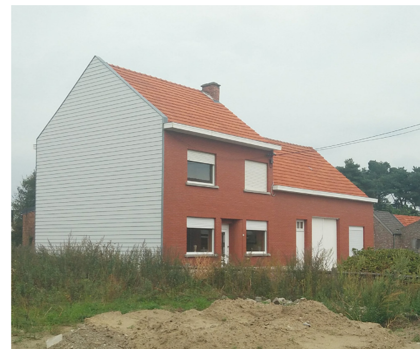
rechter buur - Hoogland nr.93 - afd. 2 sectie E nr. 564 HO - 2 bouwlagen met zadeldak
