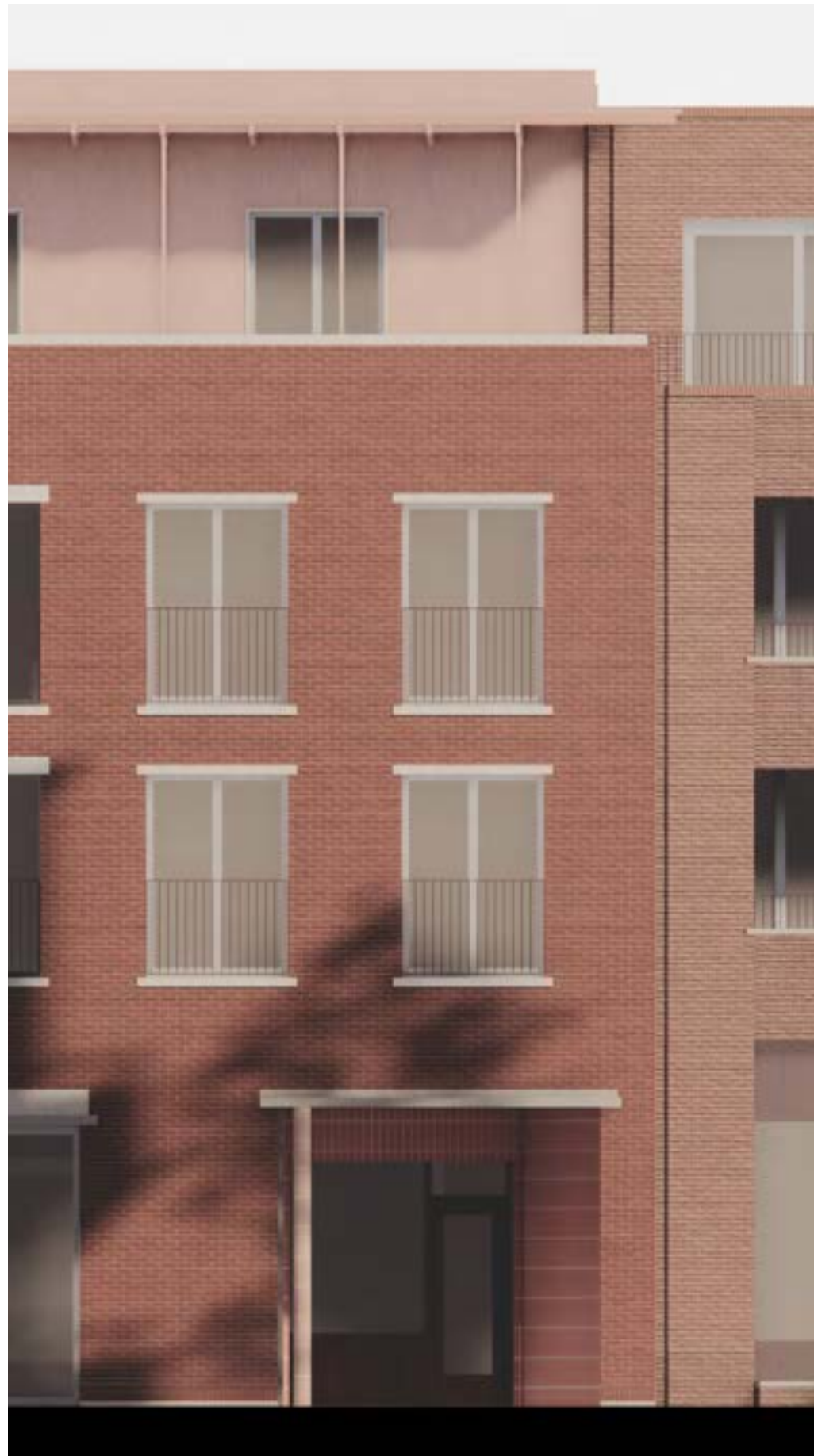
Collectieve onderdoorgang: De onderdoorgang bevindt zich in het hoekgebouw, in de verbinding tussen de twee pleinen. Een uitkragend betonelement markeert de toegang.
