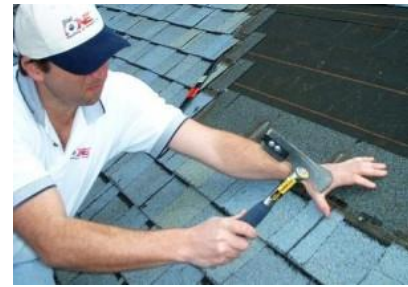
Herstellen van dak als tertiaire preventie tegen regen
